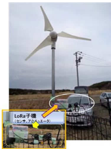
図4 西津軽郡深浦町の小型風車敷地（多摩川ホールディング社管理）設置の超小型風車支柱に付設した環境監視・振動センサデバイス（2020.3.26）
